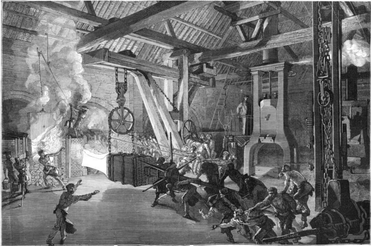
La pièce qui sort du four est destinée à un navire de la marine de guerre française. Elle va être modelée grâce au marteau-pilon à droite de l'image. L'illustration originale est ainsi légendée : « *L'énorme pièce à forger sort éblouissante du four ; les hommes manœuvrent pour l'amener sous le pilon* ».
